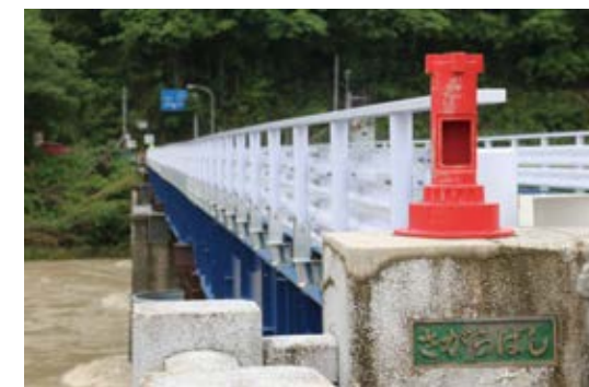
通行再開となった相良橋
