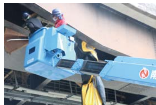
バケット車でラフトボートを撤去
