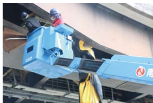
バケット車でラフトボートを撤去
