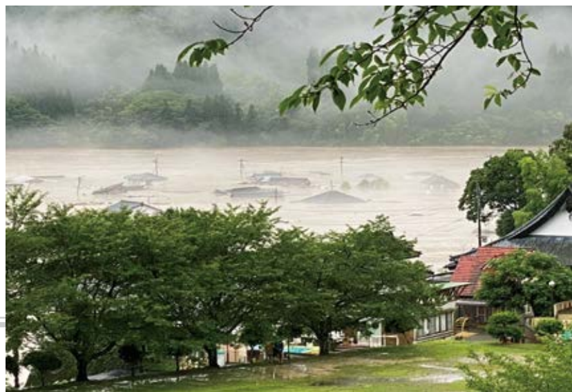
(写真2) 氾濫流に飲み込まれた今村集落
