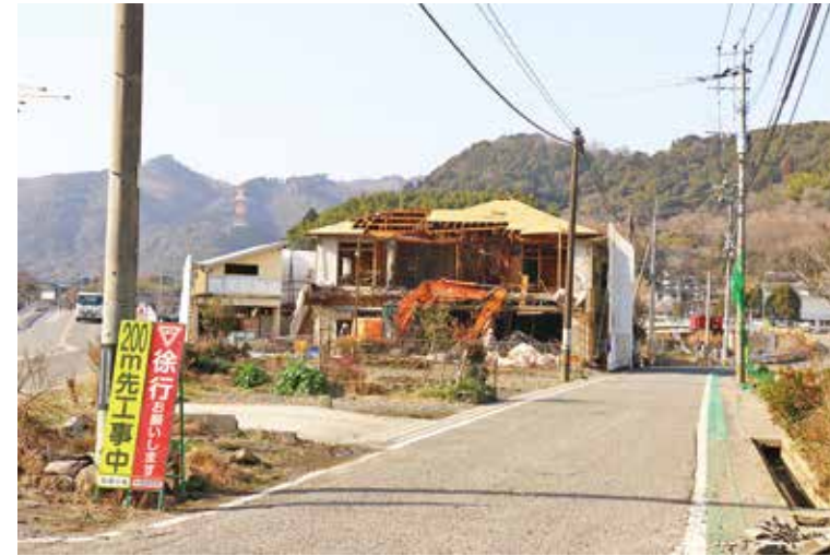
公費解体が進む住宅
