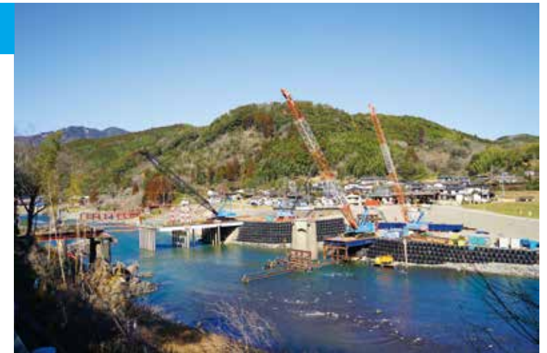
相良橋の仮橋工事の様子
