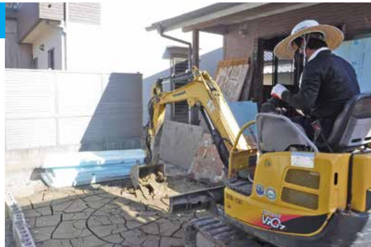
宅地内土砂堆積撤去の様子
