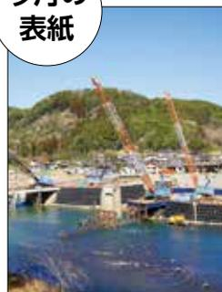
令和2年7月豪雨災害から7カ月が経過しました。復旧作業が本格化しています。早期復旧が望まれている相良橋の仮橋建設が進んでいます。5月末までに仮橋を設置完了を目指して作業をされています。
