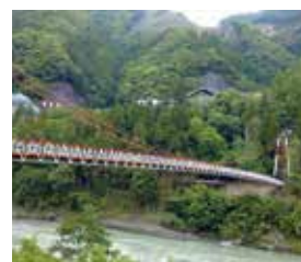
コウモリ橋改修
