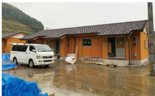
(仮称) 球磨村グラウンド仮設団地
