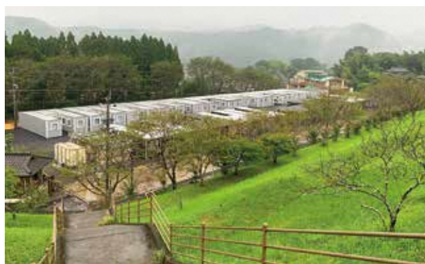
球磨村多目的広場仮設団地
