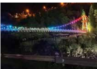
◀復旧しライトアップしたこうもり橋
