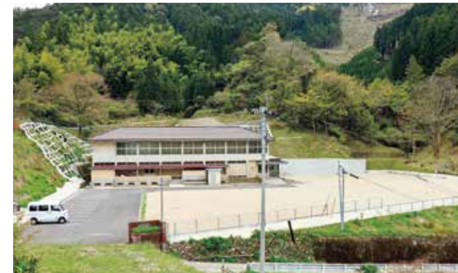
防災ヘリの離着陸も兼ねた防災広場も併設
