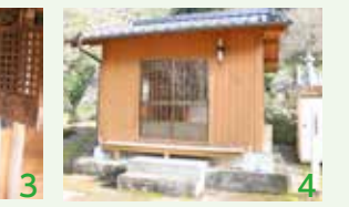
4 平成23年に改修した観音堂
