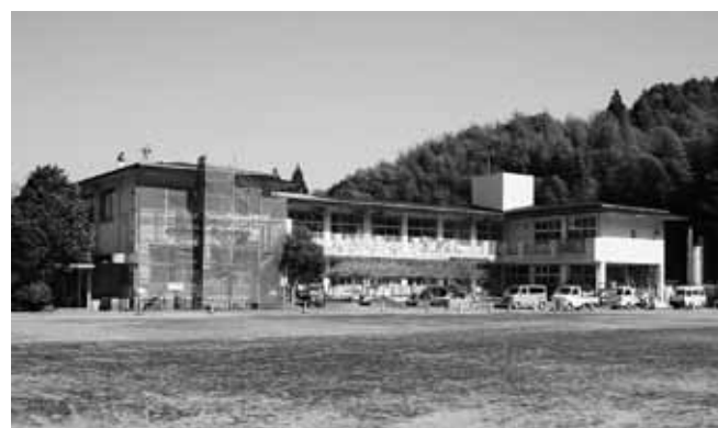
改修工事が進む旧一勝地第二小学校舎
