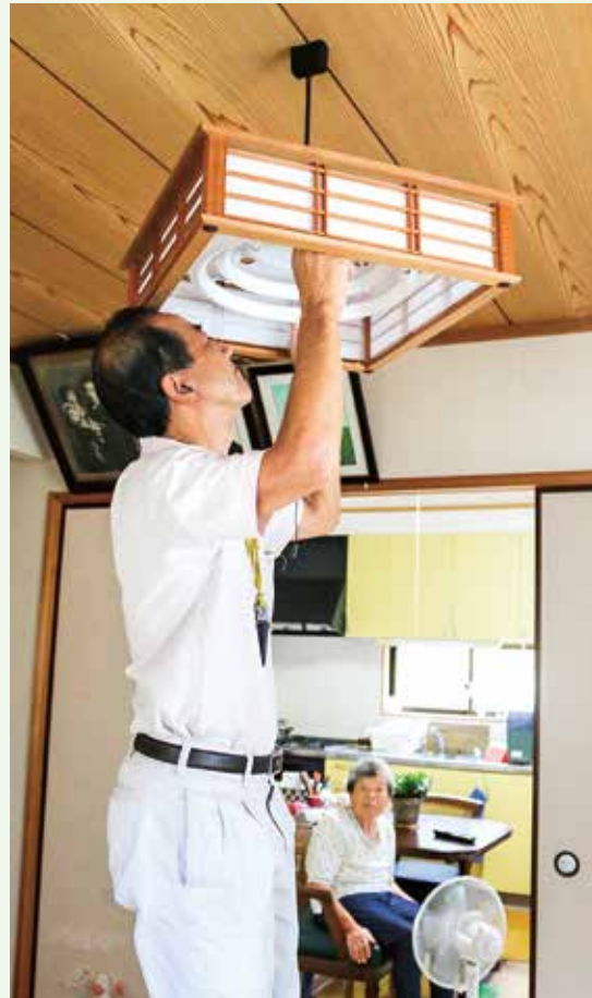
蛍光灯の交換作業
