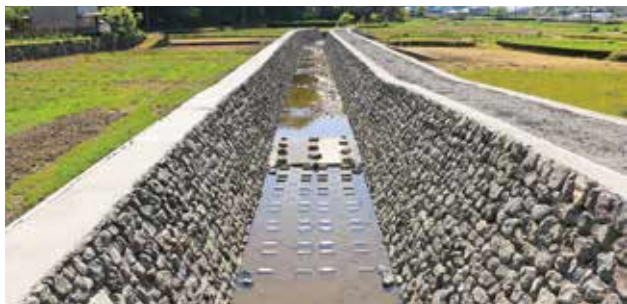
改修工事が進む峯川
