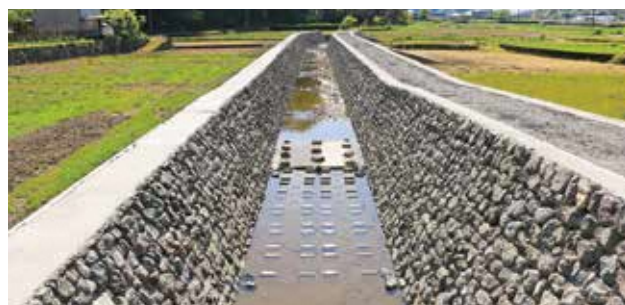
改修工事が進む峯川
