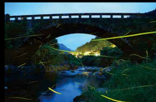
橋詰橋とホテル 瀬戸口 義継 (さつま町)
