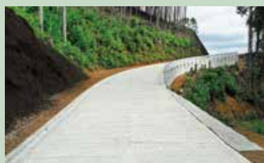
林道東俣線開設工事
