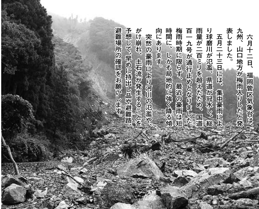
平成18年に発生した坂口地区の山腹崩壊
