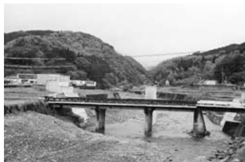
工事が進む島田地区
