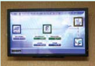
太陽光発電・蓄電システムモニター
