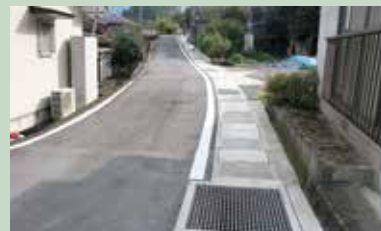
柳詰砂防関連排水工事
