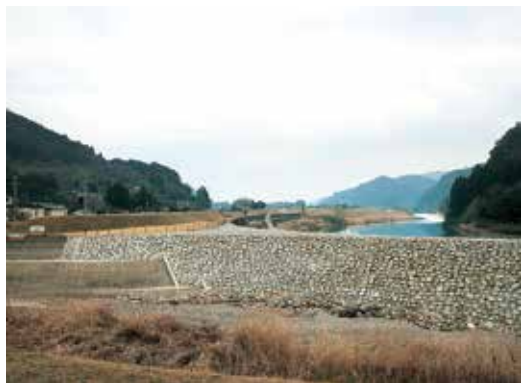
渡小川地区に設置された導流堤
