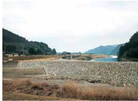
渡小川地区に設置された導流堤
