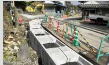
農業用水路の改修工事
