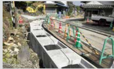
農業用用水路の改修工事
