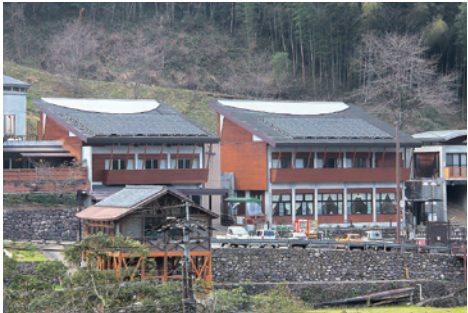
一勝地温泉かわせみの太陽光発電システム
