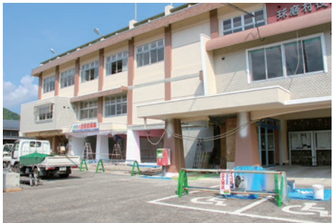
耐震改修工事が進む役場庁舎
