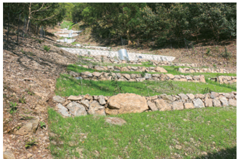
治山工事が完了した境目地区
