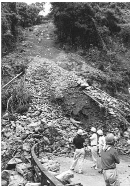
林道をふさいだ土砂崩れ
