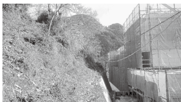
庁舎裏山の急傾斜地
