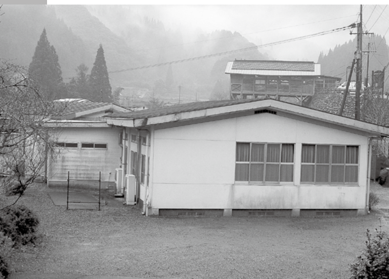
宿泊にも利用されているかわせみ別館
