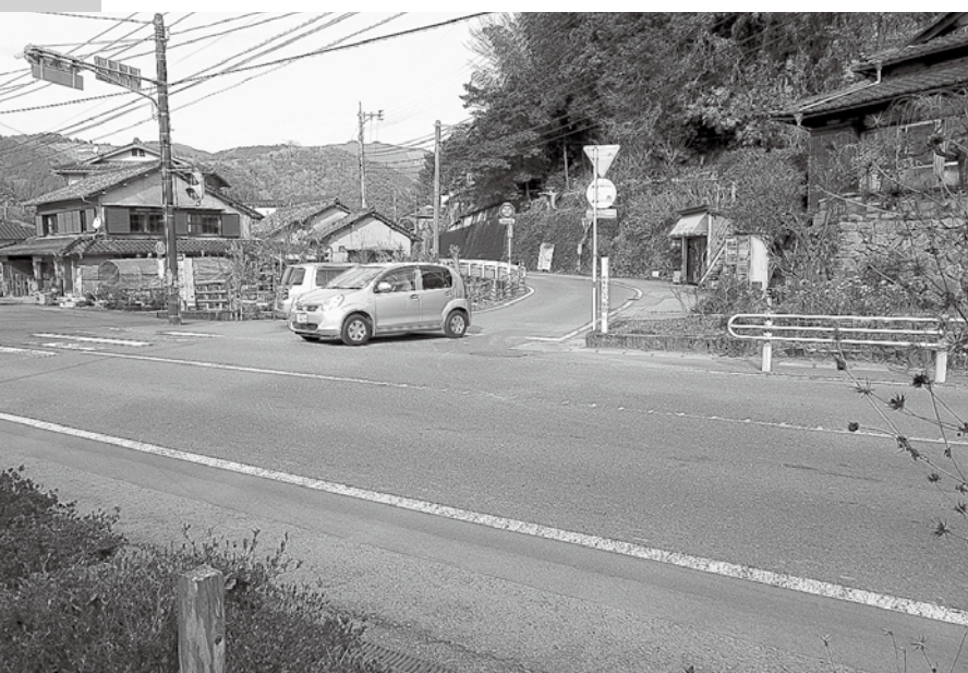
拡張工事が予定されている村道渡大槻線（渡駅前）
