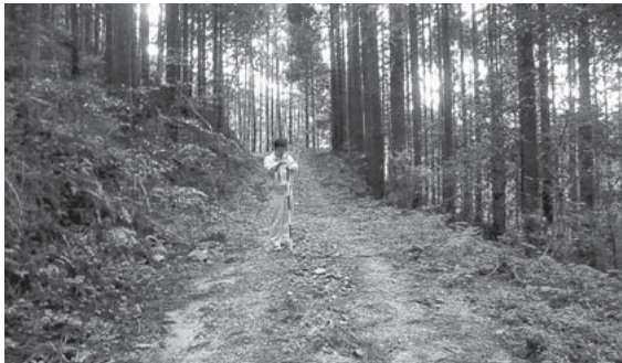
開設される林道東俣線（中間付近の黄檗地区上）
