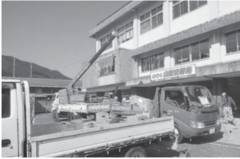
耐震改修工事が始まった役場庁舎
