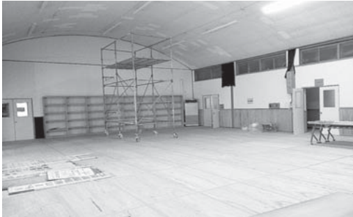
仮事務所となる清流館の移設工事
