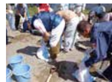
土のう詰めを一度体験！土のう詰めを一度体験！
