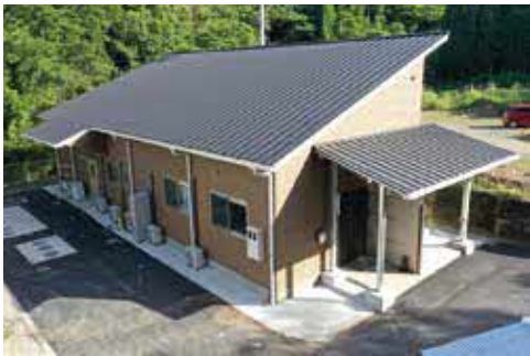
②ジビエ解体処理加工施設 (ジビエのさと)
