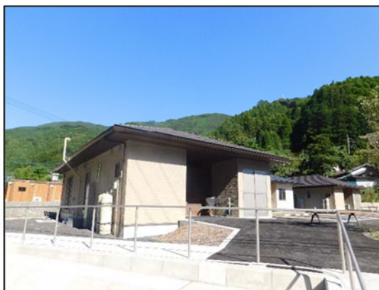
木造平屋（玄関側）
