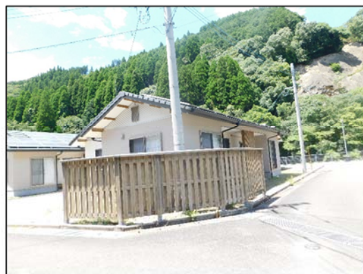
木造平屋（ベランダ側）
