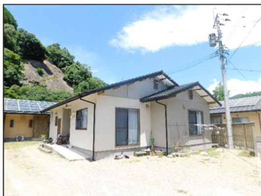
木造平屋（玄関側）
