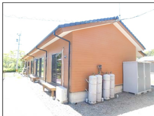
木造平屋（ベランダ側）
