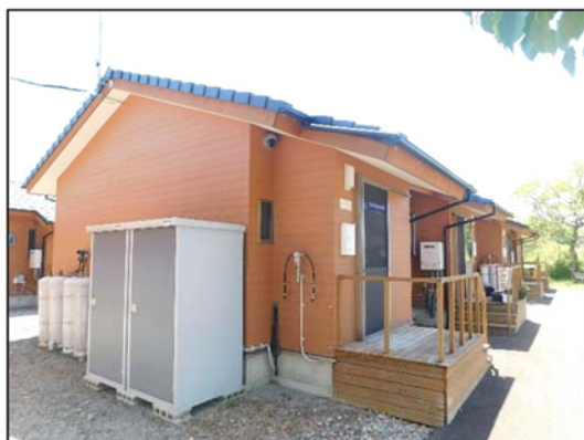
木造平屋（玄関側）
