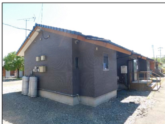
木造平屋（玄関側）
