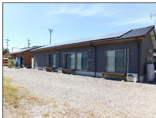
木造平屋（ベランダ側）
