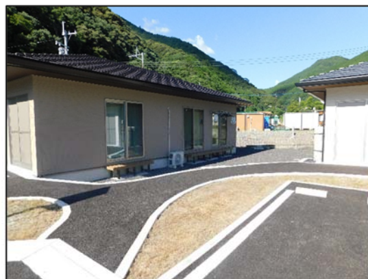
木造平屋（ベランダ側）
