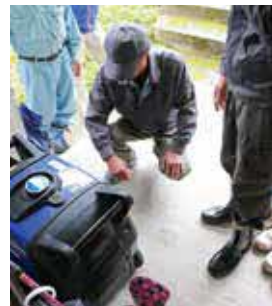
発電機点検の様子
