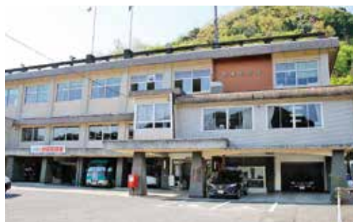
耐震改修工事が行われる役場庁舎
