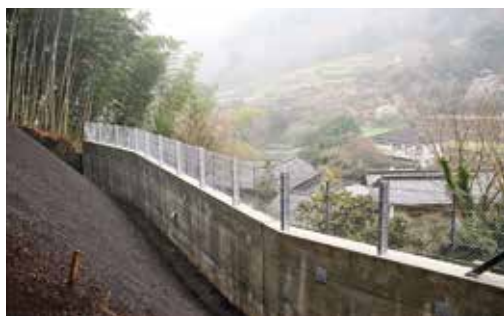
急傾斜地対策(田代地区)
