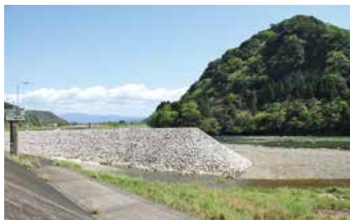
渡地区に設置された導流堤
