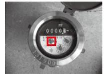
③パイロットが回転してなければ、漏水はありません。回転している場合は、メーターから蛇口までの間で漏水していますので、球磨村指定給水装置工事業者に修理を依頼してください。
