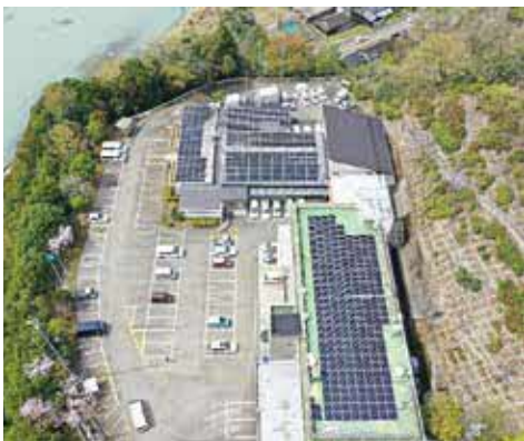
村有施設へのソーラーパネル設置
