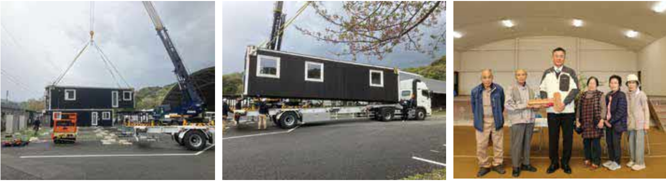
▲ さくらドーム仮設団地の解体の様子 ▲ 入居していた皆さんから鍵の返還
