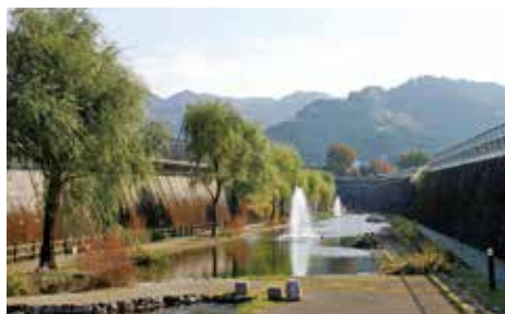
湧水トンネル
