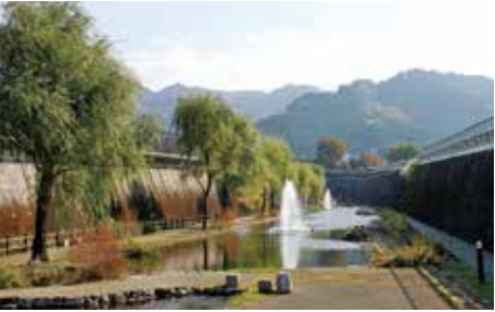
湧水トンネル
