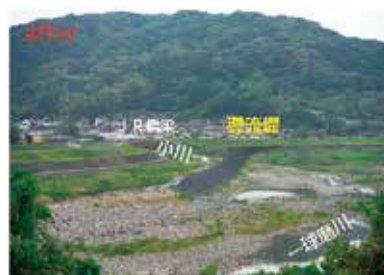
導流堤設置後
