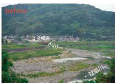
導流堤設置前
