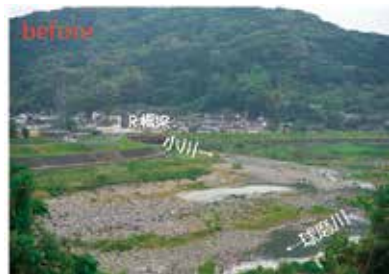
導流堤設置前
