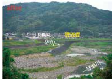
導流堤設置後
