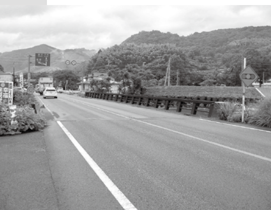
歩道が設置されていない国道の小川橋
