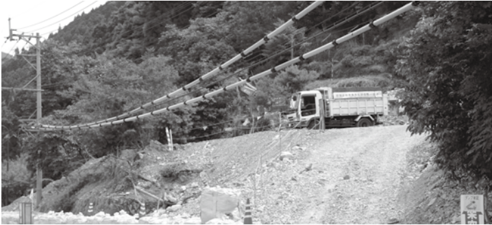
着々と復旧工事が進む神瀬一区の内谷川
