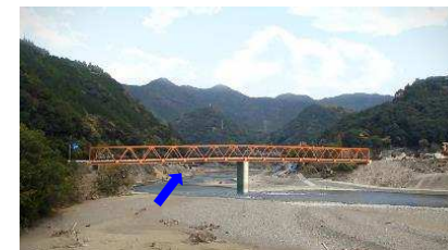
坂本橋【鋼2径間連続トラス橋】
