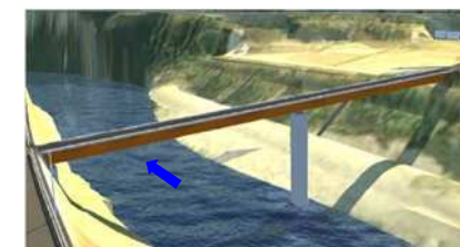
大瀬橋【鋼2径間連続鋼床版桁橋】
