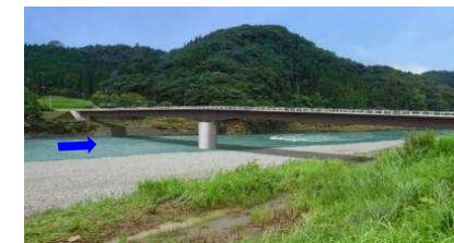
沖鶴橋【鋼2径間連続鋼床版桁橋】
