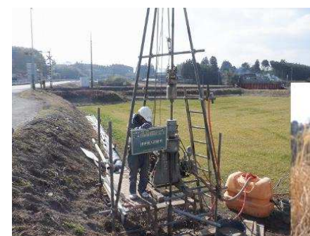
地質調査の状況 (錦町)
