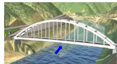
神瀬橋【鋼単純アーチ橋】
