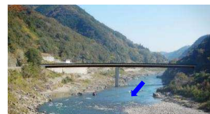
松本橋【鋼2径間連続鋼床版桁橋】
