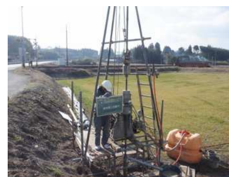
地質調査の状況【錦町】
