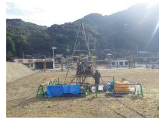
地質調査の状況【八代市坂本地区】
