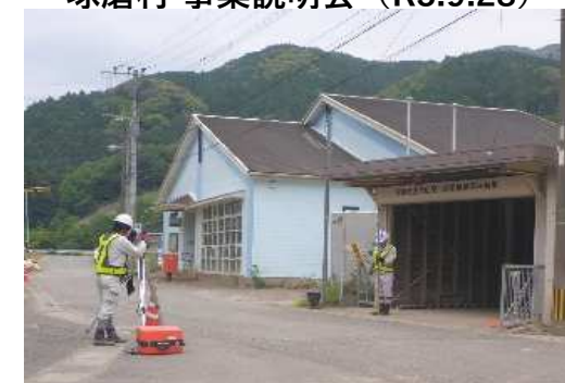
宅地かさ上げの設計・検討に向けた家屋敷高の測量状況 [球磨村]
