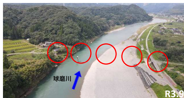
【復旧位置写真（沖鶴橋）】
