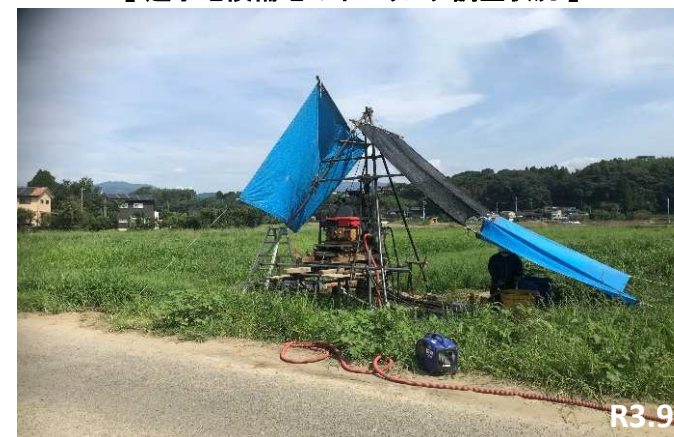
【遊水地候補地のボーリング調査状況】
