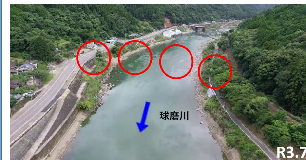
【復旧位置写真（神瀬橋）】
