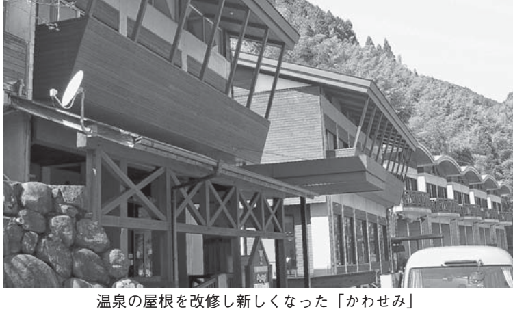
温泉の屋根を改修し新しかった「かわせみ」
