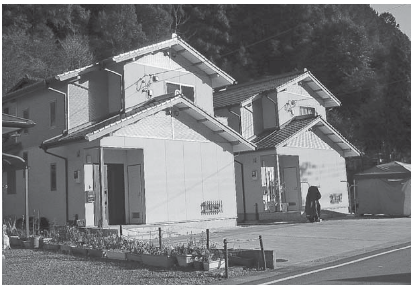
昨年建設された村営住宅（一勝地）
