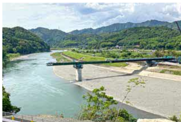
▲ 左岸側から見た、沖鶴橋の架設
