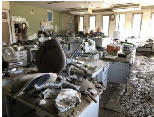
渡小学校の被害状況
