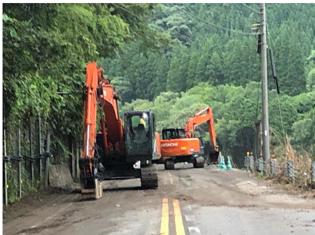
国道 219 号の復旧
