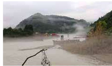
令和2年7月豪雨で流失したJR橋と相良橋
