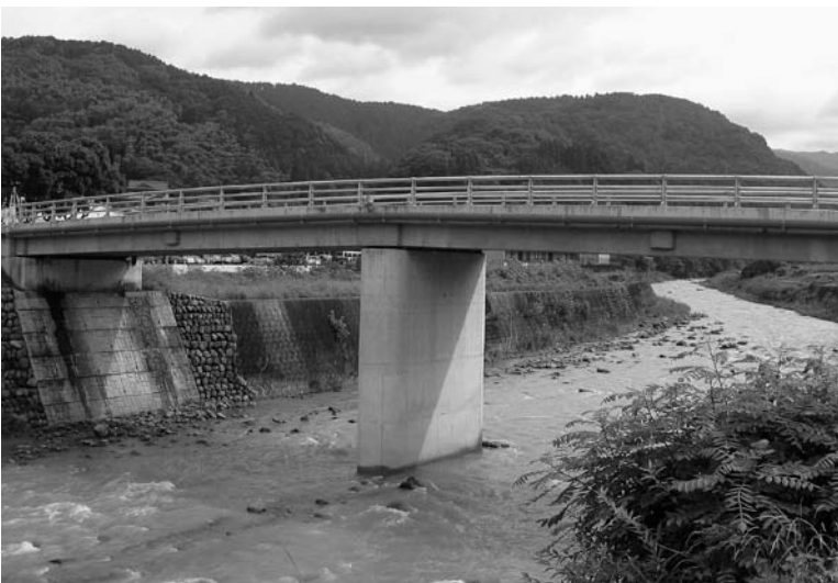
河川改修事業により新しくなった小川橋
